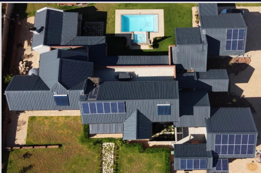
Rezidenční off-grid ESS
